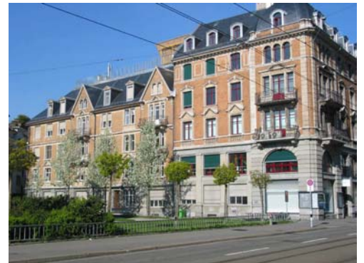
Hauseingang Seite Park: Badenerstrasse 67 Hauseingang Seite Strasse: Badenerstrasse 69
