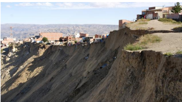
Abgerutschter Berghang, wo früher Häuser standen und die Strasse weiterführte.
