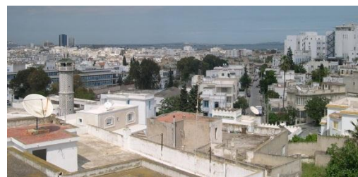
Vue de Tunis depuis le toit du bâtiment de l'EEM.
